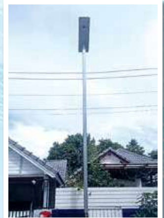
โครงการติดตั้งไฟฟ้าส่องสว่างแบบระบบโซล่าเซลล์ หมู่บ้านร้อยหลัง หมู่ที่ 8 ตำบลบางเสร่
